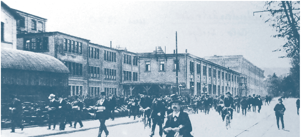
Der zunehmende Feierabendverkehr führte 1912 zum Bau der Unterführung Zürcherstrasse beim Bahnhof. (Abb. 8)
