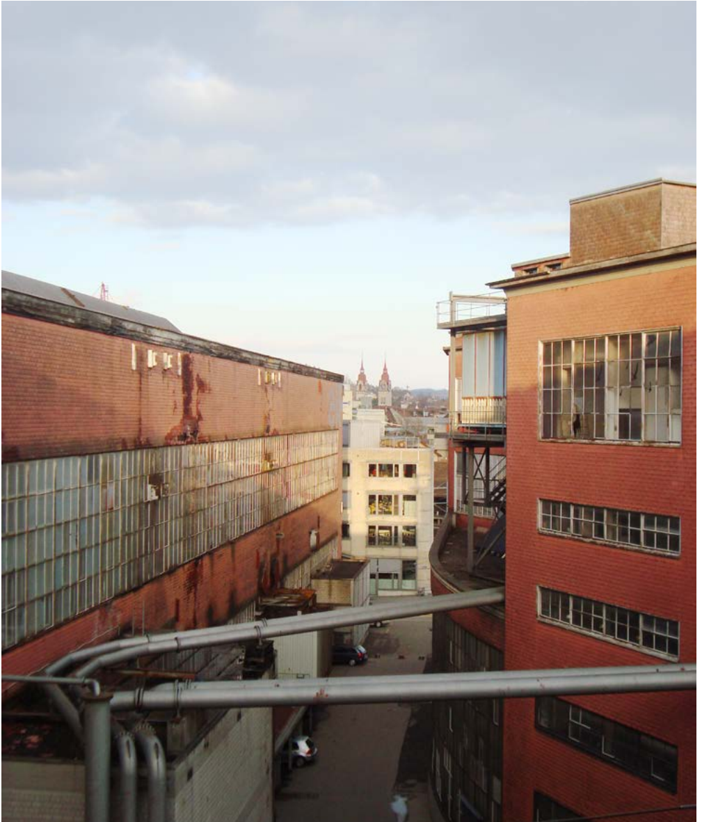
Die Hallen 11 und 87 bildeten ein städtebauliches Ensemble und harmonierten auch im Fabrikbetrieb. (Abb. 13)
