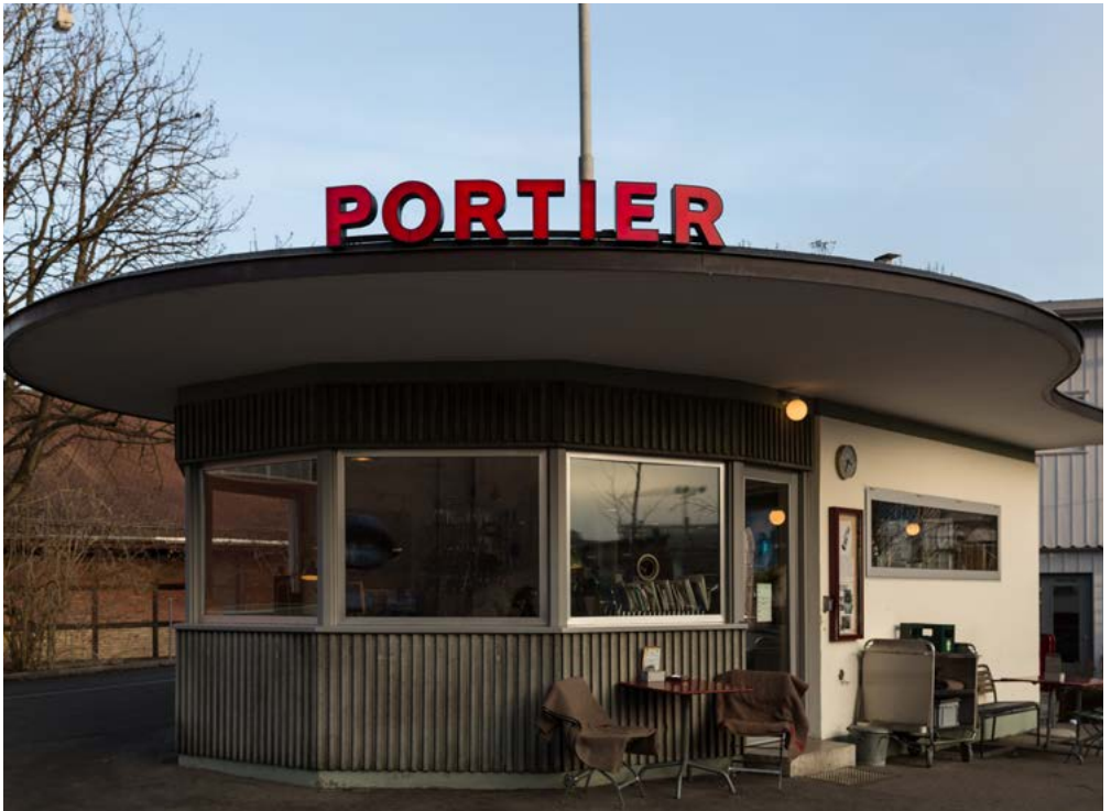
Wo früher ein Portier den Eingang ins Fabrikareal überwachte, kann heute in gemütlicher Atmosphäre gegessen und getrunken werden. (Abb. 21)
