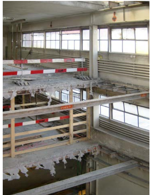
Der Umbau des Industriedenkmal stellte die Beteiligten immer wieder vor neue Herausforderungen. (Abb. 30)
