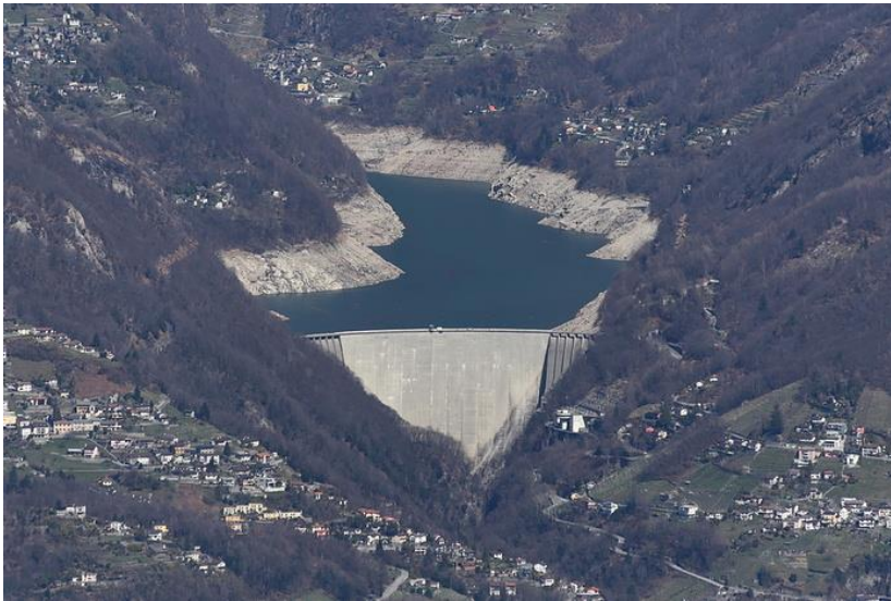
Immagine 2.2: Diga di Contra (Fonte: hikr.org)
