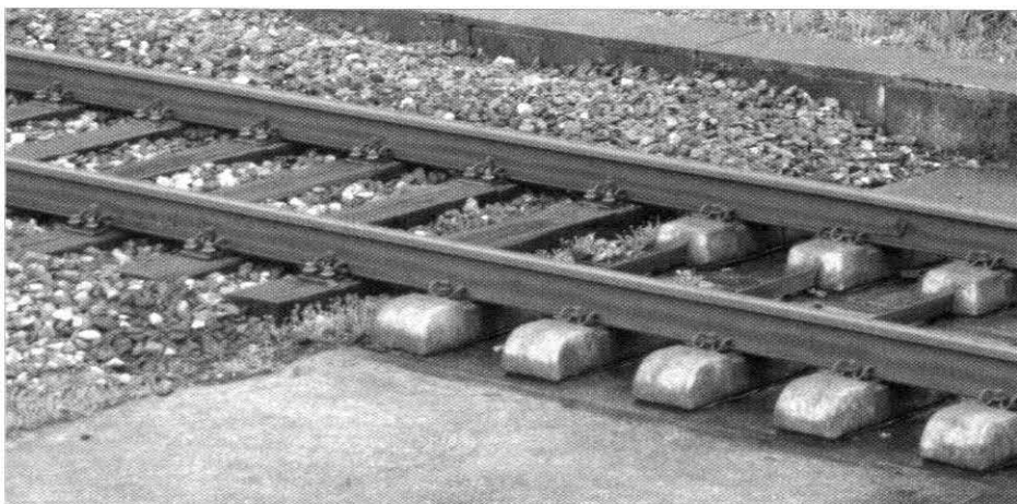
Bild 1: Übergang Schotteroberbau/Feste Fahrbahn System LVT/Grauholz in Zürich-Stettbach (seit 1989) (Quelle: Steinegger)
