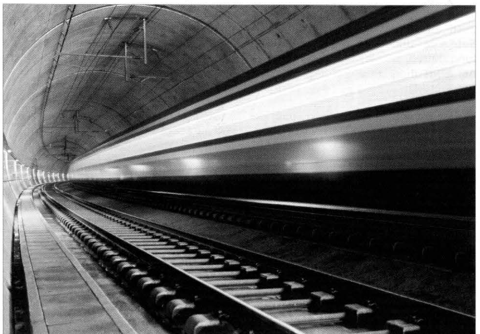
Bild 7: Feste Fahrbahn System Grauholz im Einsatz
