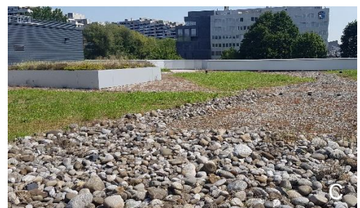
Abbildung 6: Fotografien der Dachbegrünung des Tellzentrums in Aarau; A & B: Wiesenflächen, C: Kies- und Steinfläche Quelle: C. Schlatter
