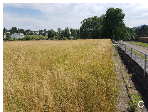
Abbildung 8: Fotografien der Dachbegrünung des Seewasserwerks Moos in Wollishofen (A-C), Quelle: C. Schlatter
