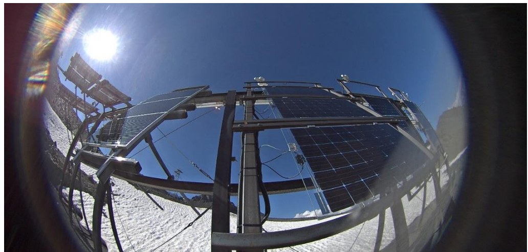
Abbildung 7: Verschattung des Segments C (links im Bild) am späten Nachmittag durch das Segment B.
