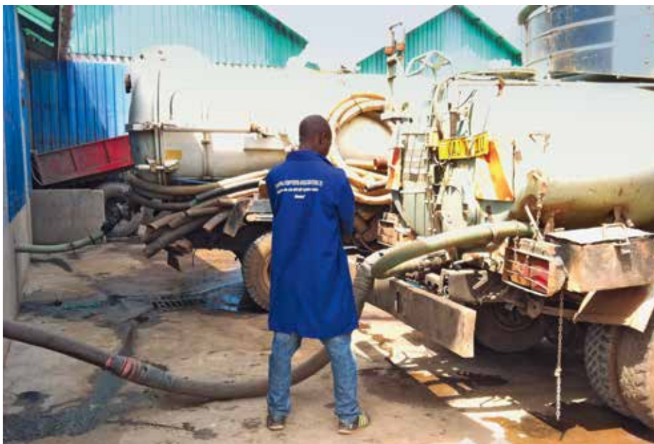
Abb. 1: Ankunft der Lastwagen mit Fäkalschlamm und deren Entleerung auf der Kläranlage in Kampala
