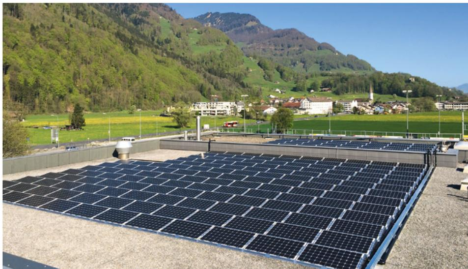
Abb. 1: PVT-Module auf dem Dach der linth-arena sgu.
