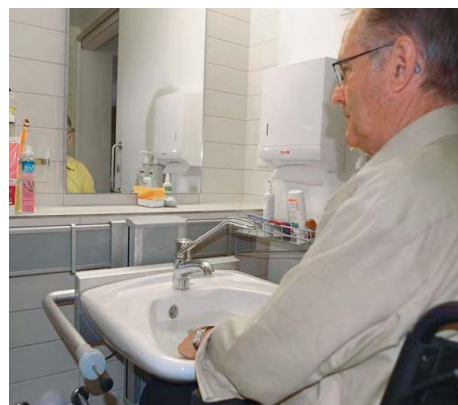
Mechanisch tief gestelltes Lavabo für Benutzung im Rollstuhl.
