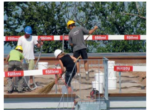
Studierende der Vertiefung «Nachwachsende Rohstoffe und Erneuerbare Energien» bereiten das Dach für die Verlegung der Photovoltaik-Module vor.
