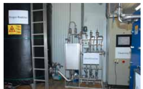
2000-Liter-Pilot-Membranbioreaktor an der Agroscope in Tänikon (ART).
