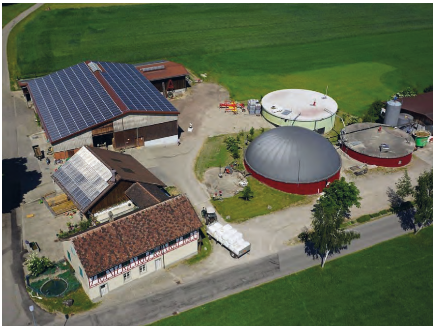
Bauernhof mit PV- und Biogasanlage. Bild: Öko-Energie AG
