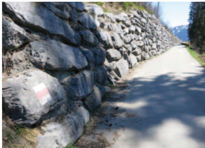
Die Strasse im Chatzenwald bei Castiel mit Blockwurfmauer und Hartbelag ist gleichzeitig Wanderweg.
