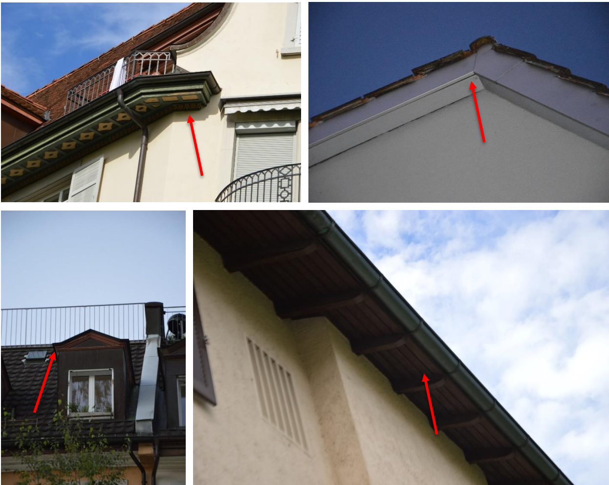
Abbildung 4: Die Quartiertypen andere Spalten (links oben), First (rechts oben), Mansarde (links unten) und Zwischendach (rechts unten).
