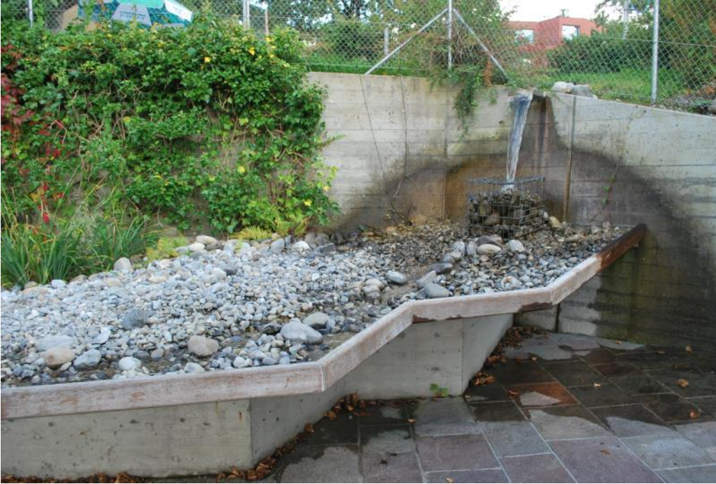
Abbildung 13: Unterfahrbare Wasserlauf auf dem Spielplatz Rodtegg (aufgenommen von D. Locher am 20.09.2014)
