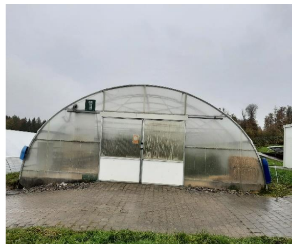
Abbildung 10: Ansicht des Versuchstunnels von aussen.
