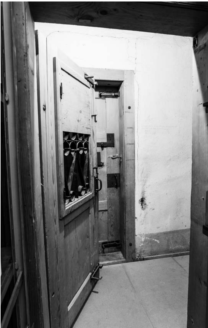
Die erste verschliessbare Türe im Dachboden, hinter der sich drei ebenfalls abschliessbare Zellen befinden.
