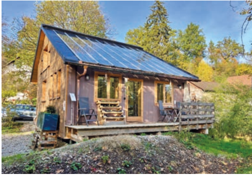
Das KREIS-Haus in Feldbach, ein Projekt der ZHAW, und des Vereins Synergy Village setzt sämtliche Aspekte der Kreislaufwirtschaft um.
