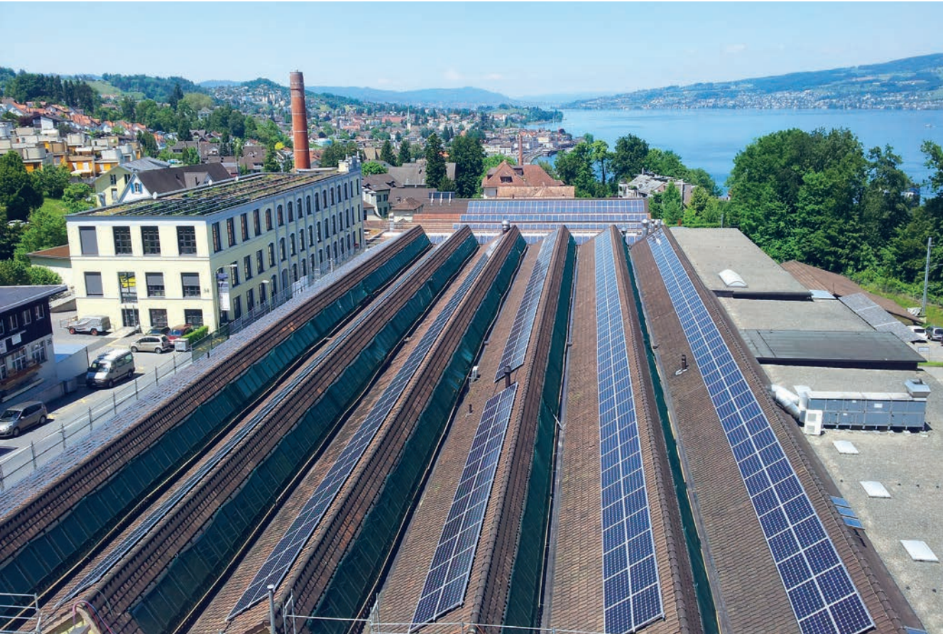
PV-Anlage auf den Dächern des Campus Reidbach.
