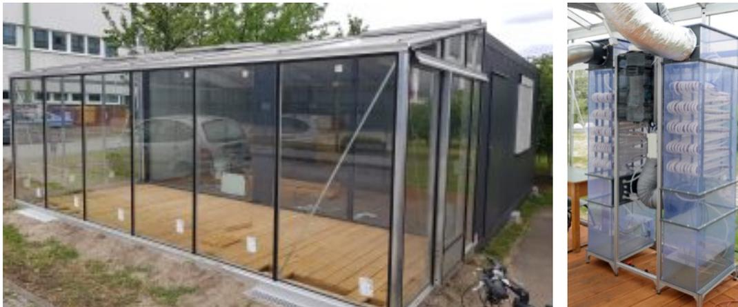
Abbildung 5: Prototyp in Berlin Dahlem (links) und Absorberbox von Watergy (rechts) [6]
