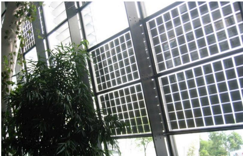
Abbildung 8: Vorgelagerte Gebäudefassade mit integrierten semi-transparenten Photovoltaik-Modulen [13]
