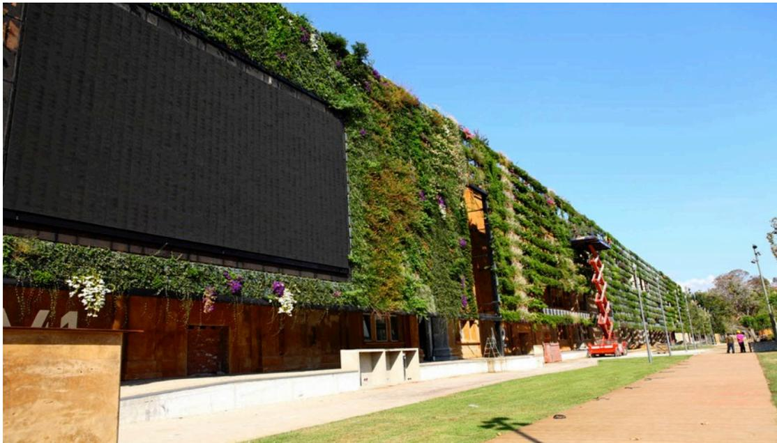
Abbildung 7: Vertikale Pflanzenkläranlage in Tarragona, Spanien [8]
