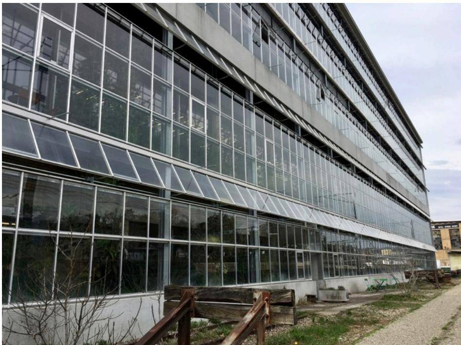
Abbildung 10: Gebäude 181 der ZHAW Winterthur von Aussen. Die vorgelagerte Glasfassade schützt vor Bahnlärm und dient als zusätzliche Wärmeisolation für das Gebäude. Der Raum in der Glasfassade dient den Mitarbeitern als Aufenthaltsraum.
