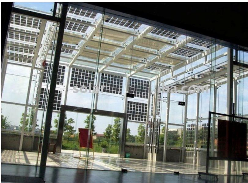
Abbildung 9: Eingangsbereich mit integrierten semi-transparenten Photovoltaik-Modulen [13]
