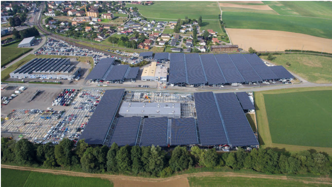
Abb. 4: Solaranlage als Überdachung eines Grossparkplatzes in Courgenay (Teil der Anlage). Quelle: https://www.edj.ch/domaines-daction/energies-renouvelables/nos-realizations.html
