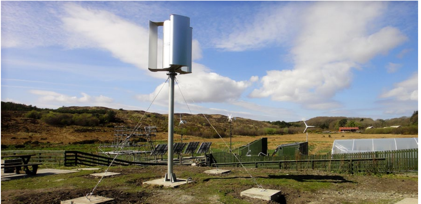
Selber geplante, zusammengebaute und errichtete Windturbine im Endzustand
