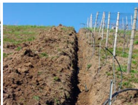
Eindrücke aus der Bauphase: Albert Steiner beim Terrassieren der Parzelle D mit einem Schreitbagger (links und mitte) und Einlegen der Bewässerungsrohre (rechts)
