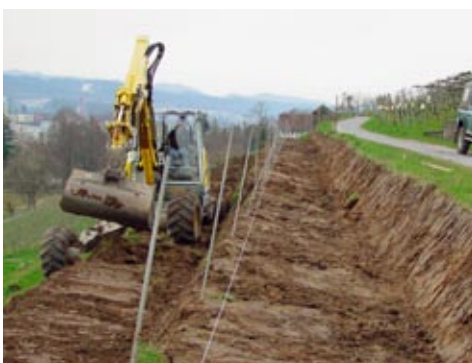
Eindrücke aus der Bauphase: Albert Steiner beim Terrassieren der Parzelle D mit einem Schreitbagger (links und mitte) und Einlegen der Bewässerungsrohre (rechts)
