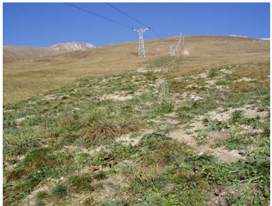
Mit standortgerechtem Saatgut begrünter Graben nach einer Vegetationsperiode
