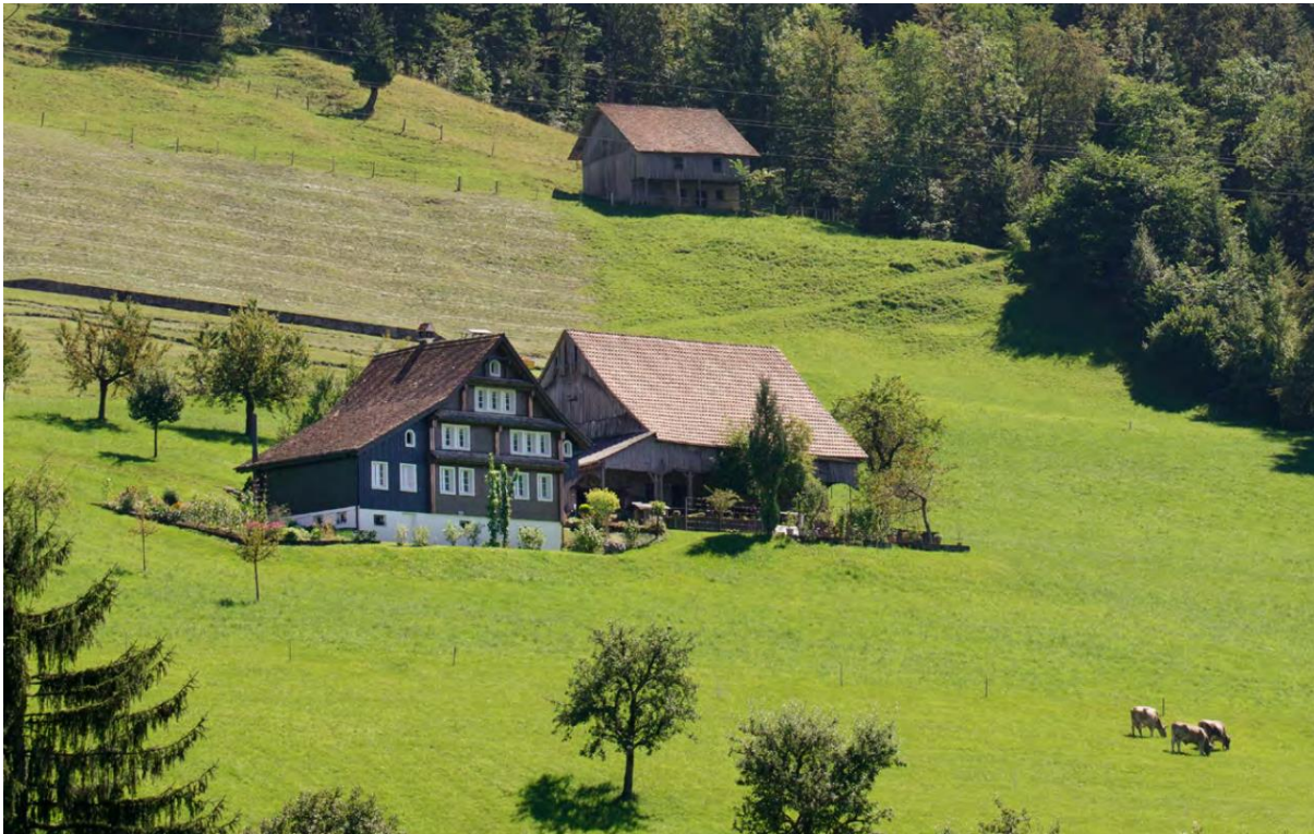
Abbildung 2 Typischer Schwyzer Landwirtschaftsbetrieb mit Satteldach (links Wohnhaus, rechts Ökonomiegebäude) (Kanton Schwyz 2017)
