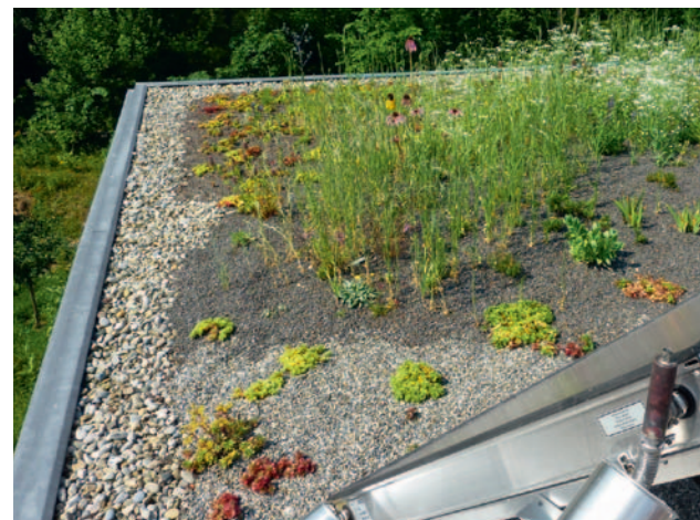
Kombinierte Ansaat mit sich versamenden Arten auf Extensivdach mit Photovoltaik.
