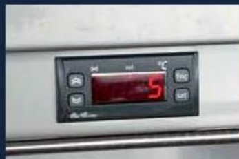
Kühlregler/Kühlanzeige zur Steuerung der Kompressor-Kühlung Régulateur/affichage de la réfrigération pour la réfrigération par compression
